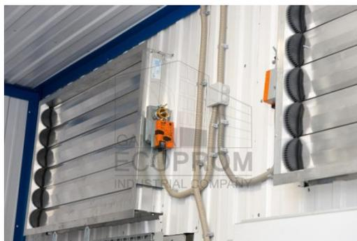
После запуска компрессорной установки лопатки заслонок с приводами AB1, AB3, AB4, AB6 открываются на угол, который зависит от температуры воздуха в станции. Регулирование угла открытия лопаток и управление работой обогревателей осуществляется с помощью ПЛК по закону ПИД-регулирования, тем самым достигается поддержание заданной температуры в модуле.
